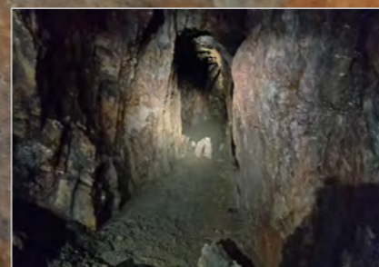
verbrochener Seitengang im - Zavalená postranní chodba - A side corridor that caved in - „Müllerstolln“
