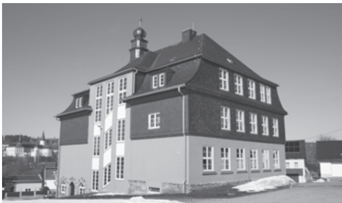
Beispiel für LEADER-Förderung in Neuhausen – Sanierung des Vereinshauses
