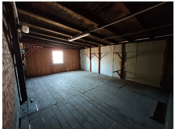
großer Abstellraum über offenem Schuppen
