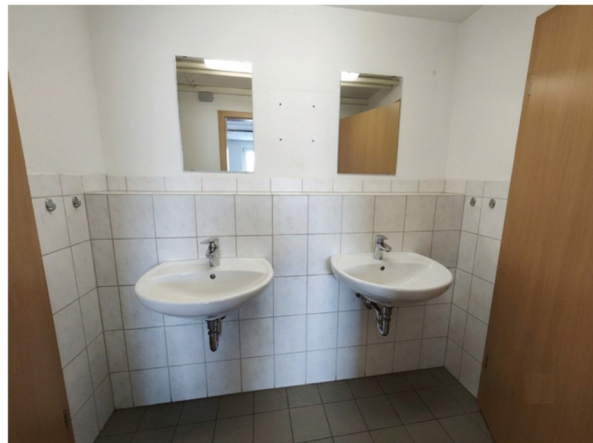
Sanitär ehemaliges Waschhaus
